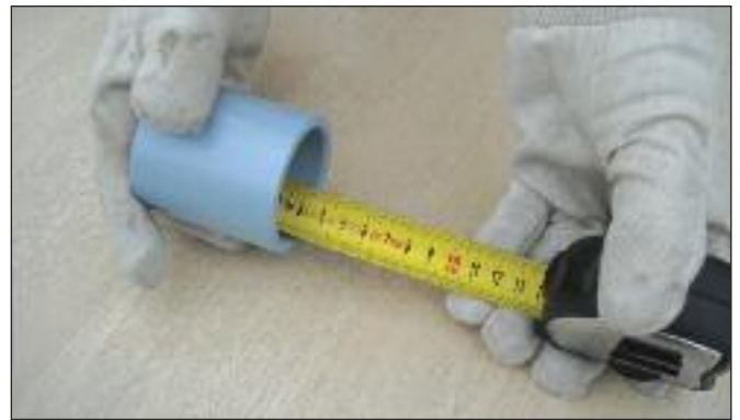
5. Measure socket depth. 測量接頭的深度
