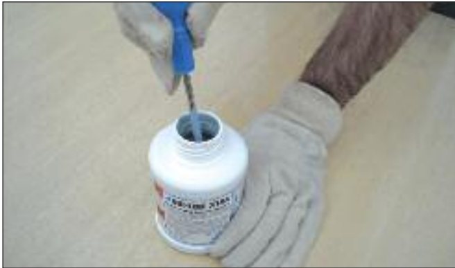
8. Stir solvent cement. 膠水使用前先攪拌均勻
