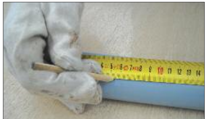
6. Mark on pipe socket depth and a known value. 在管件上做深度的記號
